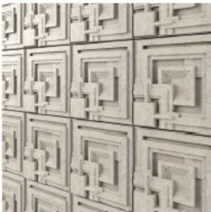
Detalle de ladrillo prefabricado de hormigón, Ennis House por Frank Lloyd Wright, 1924
